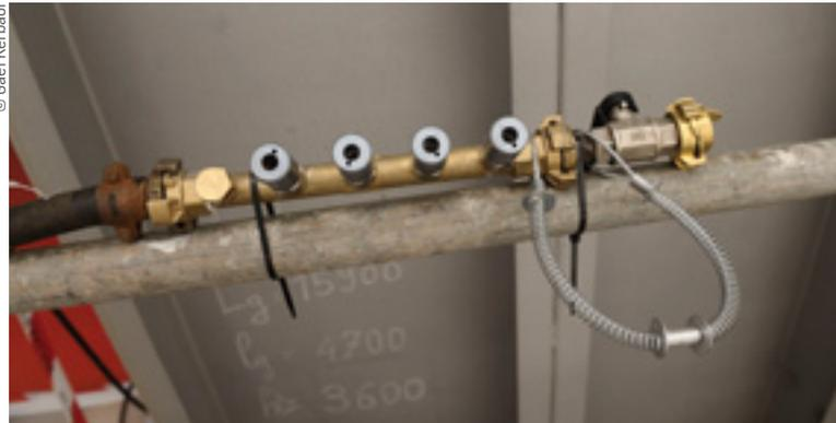
(Rampe pour alimentation en air comprimé)
