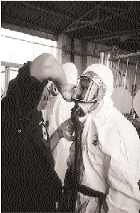
Fig. 2. La combinaison est « scotchée » ou sertie aux poignets, aux chevilles et autour de l'appareil de protection respiratoire
